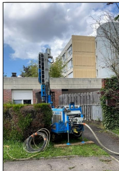
21/05/2024 : Sondage destructif avec essais pressiométriques SP2
