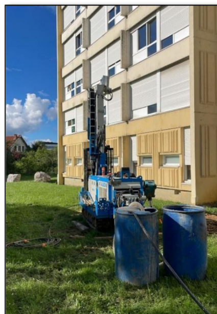
21/05/2024 : Sondage destructif avec essais pressiométriques SP3
